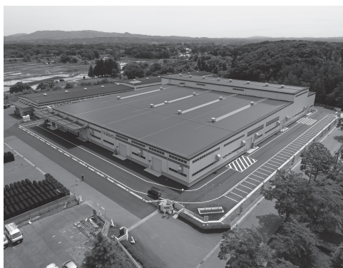
矢吹工場に新設した自社製品の工場棟
