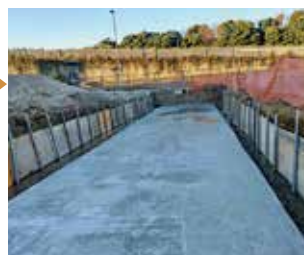
基礎コンクリート
