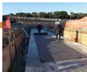
外面保護シート敷設
