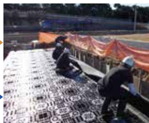
側面・上面シート敷設
