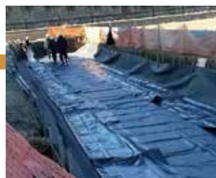
遮水シート敷設
