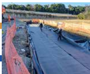
内面保護シート敷設
