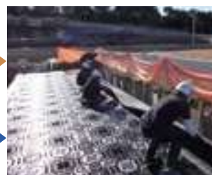
側面・上面シート敷設
