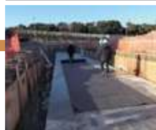
外面保護シート敷設
