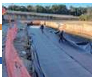
内面保護シート敷設
