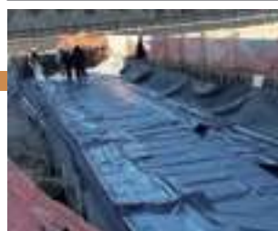
遮水シート敷設
