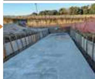
基礎コンクリート
